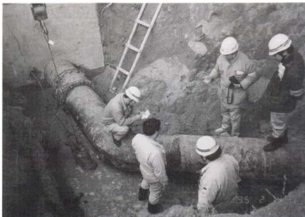
写真：阪神淡路大震災による水道管の破損の修理作業 (写真提供：神戸市水道局水質試験所)
